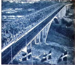
Stockholms nyaste högbro, Skanstullsbron, är en kombinerad hall- och valvbö i betong. Den har en längd av 574 meter och en bredd av 34 meter. För att bygga bron behövdes bl. n. 180.000 säckar cement och 1.800.000 kg stål.
