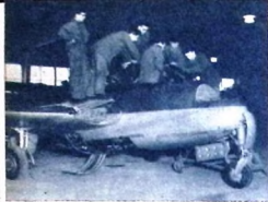
Ovan t. v. är en Vampire föremål för diskussion och översyn. En vanlig grundlig översyn tar ungefär en och en halv vecka. — Gobilnagsregatet från den på Bromma störtade Vampiren har blivit ett utmärkt instruktionsmateriel (ovan t. h.).
