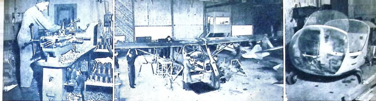
Vid en svorv typ CR 2 i mekaniska verkstaden tillverkar Gert Stenström några detaljer för Volvo. — I mitten genomgår en Fairchild översyn på flygverkstaden. — I en annan del av flygverkstaden ombyggs en helikopter för besprutning av skadelsekter. (ovan t. h.)
