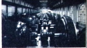
Interiör av generatorhallen i kraftverket vid Trollhättan. På bilden ses 13 generatorer vilkas utvecklar ca 150 000 hk.
