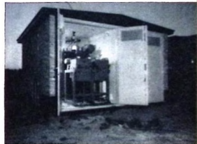
Ovan: En nästation för nertransformering från 6 000 volt till 220 volt. Transformatorblokar av denna typ finns bl. a. i Stockholms förestäder. — Nedan: Kontrollrummet i Elverkets huvudkontor i Stockholm. Ett stort antal militära och kontrollapparater i registret ser hela tiden kraftförbrukningen i Stockholm och härifrån kan man även följa allt som händer och sker på nätet, hela vägen från Indalsälven och Dalälven.
