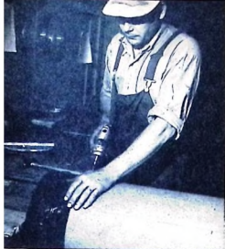
Nitningen utförs med hjälp av elektriska borrar.
