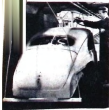
Färgen sprutas med tryckluft. T. v. ses svantengårdens — vatten som rinner utmed en plåtvägg.
