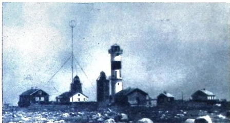
Nidingens fyrplats sydöst om Gullskär ett bra stycke ut i havet fick för ungefär ett år sedan en ny delvis automatisk fyr — den höga vita — i stället för den gamla dubbeltyten, de två granittornen. Den nya fyren är utrustad med ljusfyr, radiosändare och elektrisk membranström.
