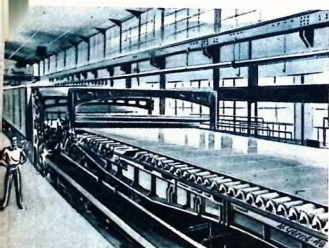
En pappersmaskin. Närmast syns viran, följd av guskpress, våtpressar och torkcylindrar.
