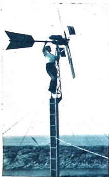
En 1.000 watts vindgenerator på Vinga. Chefen för den här förlagda marina avdelningen, styrmann Bredefeldt, har klättrat uppför den 15 meter höga, stabila och mestadest järnbeholvar 1 klippor väl stegade masten för att utföra en justering på generatoren. I bakgrunden kan man — åtminstone i verkligheten — skåda Carlstens fästning i Marstrand.
