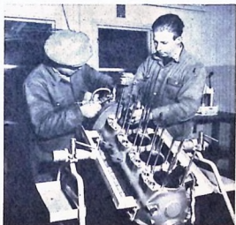
Reparation av Gipsymotor
