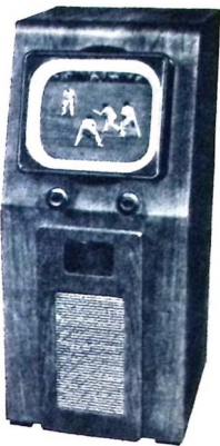
En engelsk televisionsmottagare, som kostar omkring 300 kronor. Bildretorten är ungefär 10 x 20 centimeter.
