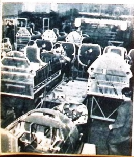
5 Här ses ett antal framkroppar under detaljmontering innan de monteras på mättingarna. I bakgrunden monteringsbanan.
