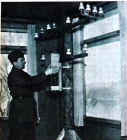
Ljtnant Håkan Steene demonstrerar anordningarna på en ledningsstolpe varifrån ledningarna går direkt in i en växelstation. Så småningom skall man i en trådhall i minstyrbu ha allt som finns i verkligheten i fråga om tråd och trådförbindelser.
