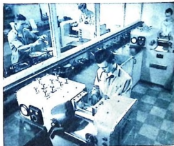
Provbak av nya material som sammansatta i laboratoriet blandas i dessa små kärnor. Provet gjöts sedan eller vulkaniseras och skickas till provningslaboratoriet för elvalvering.
