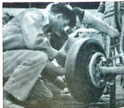
På asfaltbanor används släpplids däck som är omöstrade och som ger bättre grepp.
