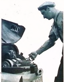
Vagnen saknar självstart och motorn måste dras i gång med snöre som en aktersnurra.
