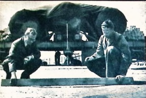
Ingenjörerna Hernel (t. v.) och Idebrand mäter den beräknade deformationen, som i detta fall uppgått till närmare 1 tum efter belastning med 100 ton. Den ytan duger inte.
