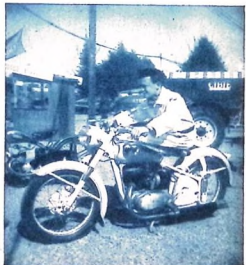
Här provställer Vallner Andersson den österrikiska 250-kuhkaren Puch. Maskinen har dubbelkolvmotor med en effekt av 12 hk vid 4.500 v/min.
