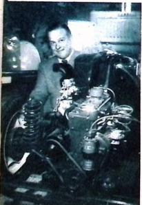
I den franska bilsalongen visade Renault bl. a. motoraggregatet och bakhjul-upphängningen på lilla 4 CV. Motoreffekten är 19 hästkrafter.
