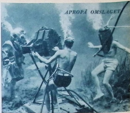
Undervattensfilmare i aktion. T. o. m. klappan finns med. Denna kamera är fäst vid en nedslänkbar plattform. Som synes varierar personalens dykarutrustning högst betydligt.
