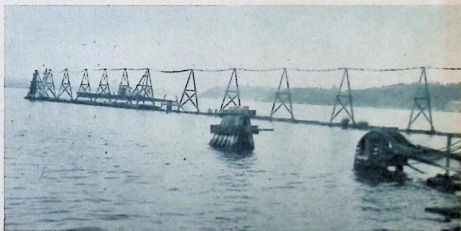
En del av den 200 meter långa nollslingan, vars undera längda löper på sjöbotten och vars normal pekar mot den magnetiska nordpolen — utläsa med i vattnet mot Lidingön t. h.
