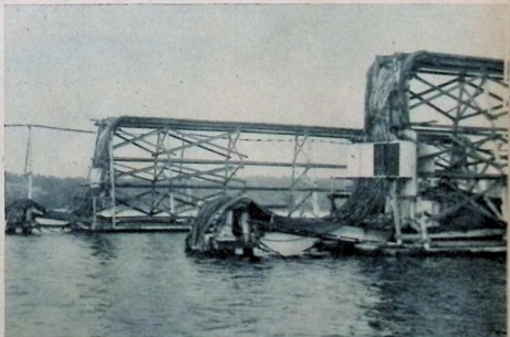
Avmagnetiseringsslingan, som matas med lågperiodig växelström, består av fyra stycken U-skiuklar, varav två är placerade ovanför vattenytan. I bakgrunden skymtar nollslingan.
