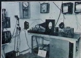
Den automatiskt registrerande meteorspaningsanläggningen består av ett 30 cm:s katodstrålerör samt framför det en filmkamera som tar en bild var femte sek. Vänstra klockan anger lokaltiden för Göteborg.
