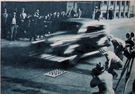
Experiment med Life-Guard-däck i USA. Bilen får med högsta hastighet köra över en platta med sylvassa stålspetsar. Däckat och den yttre slangen går givetvis sönder, men den inre håller. Denna slang har förvandlat ringexplosionen till en lätta. Vid ut-
