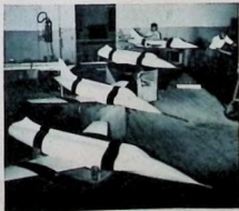
De första flygförsöken med F-90 gjordes med modeller, av vilka några här ses under montering vid Lockheeds stora laboratorier.
