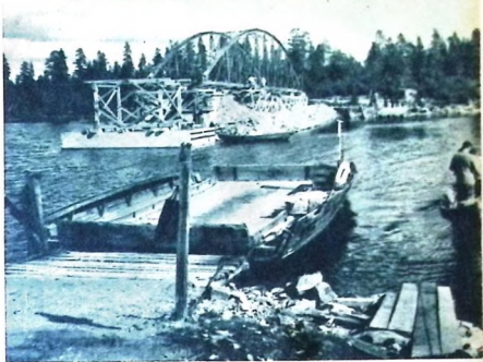
Den gamla bron i Stensele bestod av sex valv. Ett av dessa fraktades till Flyggsundet där det sattes ihop på en glidbana. Den gamla färjan i förgrunden.
