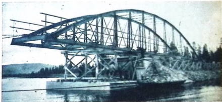
På två sammankopplade pontoner, som lånats från Ing. 3 och som hade en bärlast på vardera 20 ton, drogs bron ut över sundet med ett vanligt handspel.
