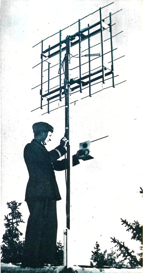
Sven Linnfors justerar med fältstyrkemätaren riktantennen för 68 cm mikrovågor. Antennen är av typen "broad side" med 32 halv vågslipoler (34 cm långa), som ger en förstärkning av 100 gånger i riktning mot Stockholm. Nederst i bakgrunden skimtar Uppsalaalätten — antennen är monterad på toppen av ett luftskyddstorn på Galgbacken alldeles intill Uppsala.
