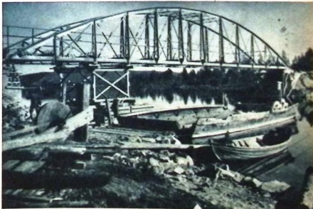
Bron är i det närmaste färdig. Detta slöt att bygga en ny bro av en gammal anser dock inte brobyggarna var en lycklig lösning. Trafikanterna är dock nöjda.
