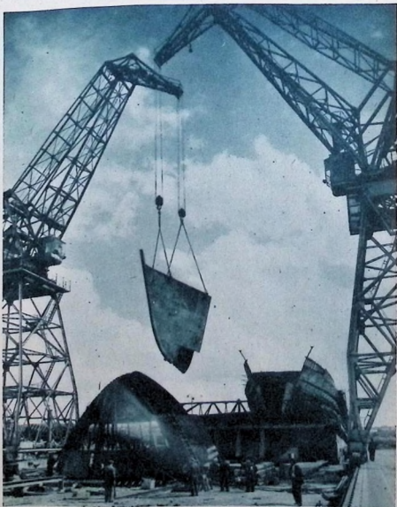
Ett löpsvetsat parti av fören till ett tankfartyg lyftes på sin plats av två lyftkranar. Under 1948 byggdes i Sverige 76 större fartyg, därunder 14 vid Eriksbergs varv i Göteborg.
