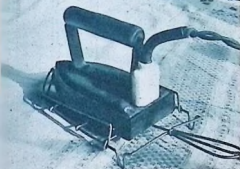
Det här gamla strykjärnet är både omdö- derent och farligt. Skyddshysan saknas, stift- et är sönder och ligger öppna för berör- ning, och metallspiralen åter för eller se- nare upp sladden. Kan orsaka kortslutning.
