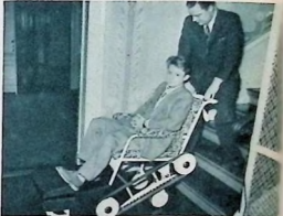
En dansk ingenjör har konstruerat denna rullstol som även kan dras upp för trappor. Stolen har en liten elmotor som driver »larvfötterna» som är av gummi.
