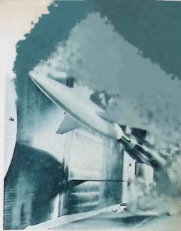
I denna vindtunnel provas nya projekt i hastigheter upp till 2.000 km/t. För att åstadkomma ett så kraftigt »drag» fordras inte mindre än 50.000 hästkrafter.
