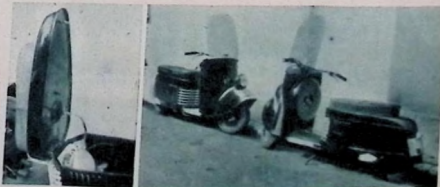
V. v.: Bränsletanken är placerad under sadeln och rymmer 12 liter. — T. h.: Bernadet är »italienska» i utformningen, men utifrån det är kanske inte fullt lika elegant.
