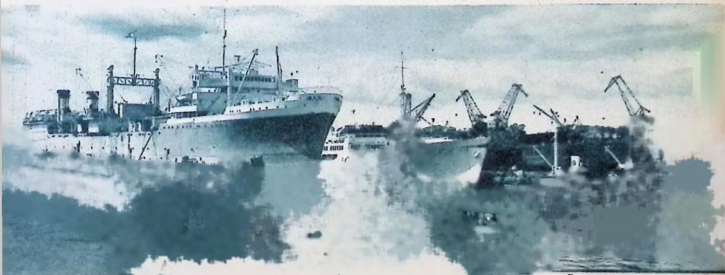
En översiktsbild av Eriksbergs tre flytdockor, varav den största — t. v. — kan lyfta 23.000 ton; på mindre än en timme släpper den
