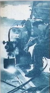
Man använder modernaste automatsvetsapparatur.
