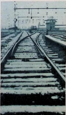
På spåret rakt fram kan tåget passera bangränsen med ända upp till 120 km hastighet, genom växelkurvan t. h. är maxfarten 40 km.
