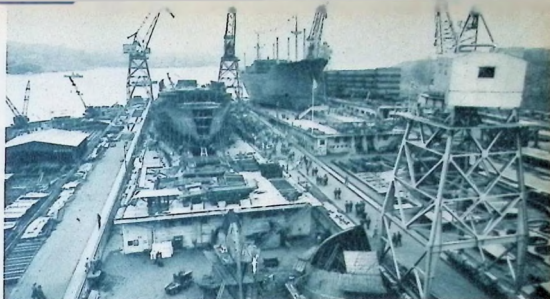
Skrovtillverkningen är förlängd till de tre nya biddarna. Tankfartygen är på ca 10.000 ton d.w. I förgrunden syns sektioner till kommande fartygsbyggen. Allt material placeras inom räckhåll för lyftkranarna.
