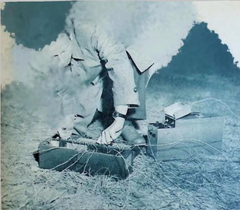
Kandidat Ulf Langefors med sin Intervallkopplare. Den är försedd med ledningskontroll och rullar med ledningstråd som kan anslutas direkt till sprängkapslarna. T. h. tändeggregatet.
