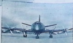
Bild framifrån, visande de dubbla hjulen och det höga stjärtpartiet, vilket gör ytterligare trimning överflödig vid ändring av motorstyrka eller infäl- ning av klaffar och landingsställ.
