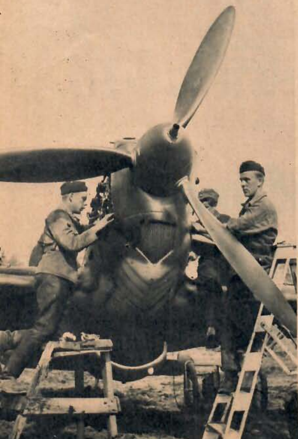
Hispano-Sulza-motorn på en Morane-Saulnier 406 (bilden t v) tas under översyn av finska mekaniker. Lagg märke till den är spinneren utskjutande 20 mm akannymningen.
