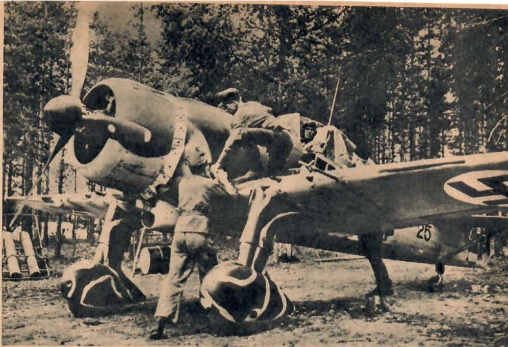
Här ovan ett startklart licensstillverkat jaktplan av typ Fokker D 21. Motorn är en 830 hk Bristol »Mercury VIII» och beväpningen utgöres av fyra fasta 7,9 mm ksp.
