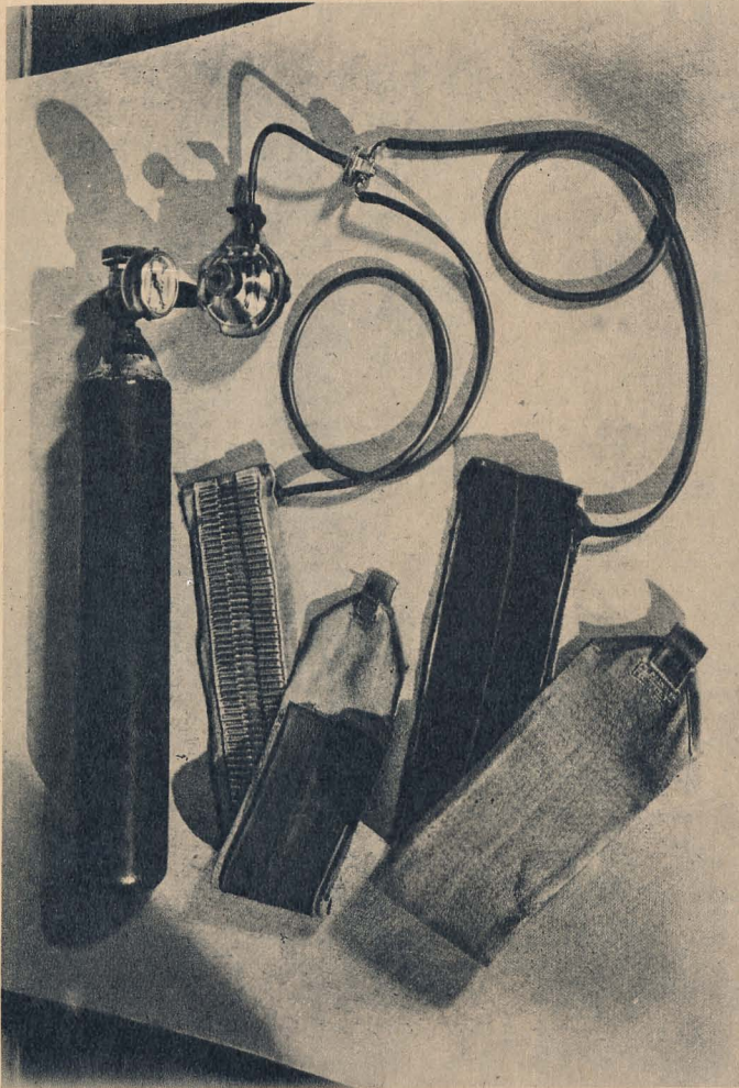
Bild 2. Blodtrycksmanschetterna uppblåses från en tryckluftbehållare.
