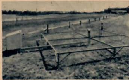
Fig 6. Markeringsfyr med sändarskåp, motviktsnät och antenn.
