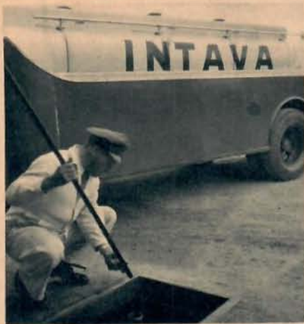
Gustav Ahlström gör här ett av de dagliga vattenproven med reagenspapper i Intavas Jordtankar på Bromma.
