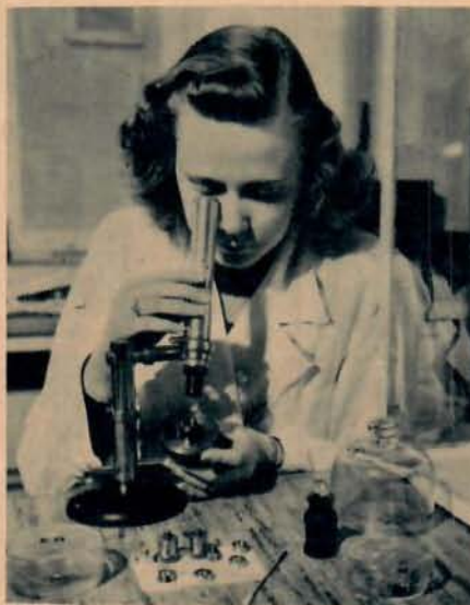
I ABA:s instrumentverkstad på Bromma kontrollerar fröken E. Mattsson med mikroskopets hjälp flygplanets »balanslinne».
