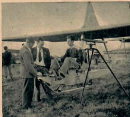
Chefsinstruktören för segelflyget, Bengt C:son Bergman, och gungans konstruktör Herman Butz tittar på medan en elev provar roderharmonien i balansgungan på Alleberg.
