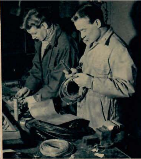
I ett modernt trafikflygplan finns det massor med elektriska anordningar och en flygmekaniker måste även vara elektriker. Arne Roth och Nore Andersson sysslar med ett signalsystem i DC-4:an. ABA har planerat att ordna specialkurser för elektromontörer som måste stå klara att ta emot DC-6:orna.
