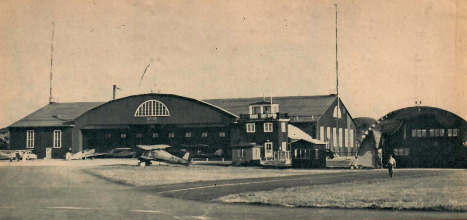
Ovan: Den enda hangar som finns på Torslanda byggdes 1923 av trä och liknar mest av allt en gammal dansbana på landet. Den rymmer endast en DC-3:a, men för att något avhjälpa bristen uppförde man förra året en noshangar intill.
