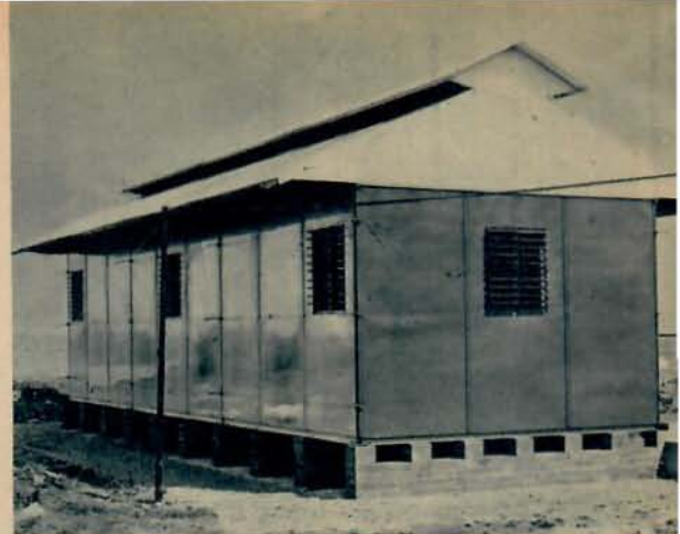
Ovan och nedan: Bristolfabriken har börjat tillverka s. k. tropikhus för flygfält i heta trakter. Husen är gjorda helt i aluminium och försedda med ett finurligt ventilationssystem i taket.
