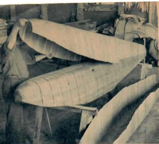
Ovan: Det färdigbakade flottörskalet och bakningsmallen. — T. h.: Kockums Flygindustri's Luscombe Silvaire blir det första flygplan som utrustas med de nya träflottörerna.
