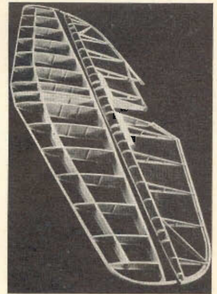
Fig. 7. Stabilisator och höjdroder utan klädsel.
