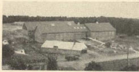
Från byggnationen vid F 14.
