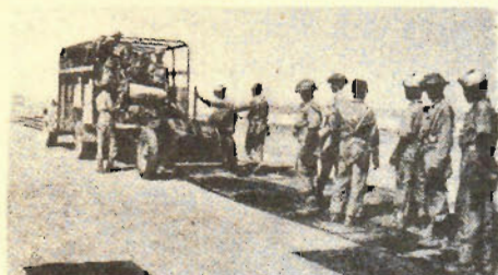
Fig. 1. Läggningsmaskin för P. B. S. (Prefabricated Bituminous Surfacing) med "frimärksslickare".
