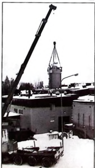
Så här såg det ut när den flera ton tunga värmeuget lyftes in i det hus som byggs för den nya kompressor-anläggningen.
