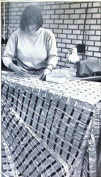
Susanne Nordkvist reparerar bromsfallskärmen till flygplan 35. Den utsätts för stor belastning vid uppbromsning efter landning. Det ställs stora krav på sömnaden för att klara dessa belastningar.
