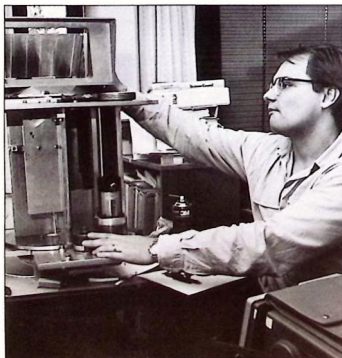
Håkan Palm och Magnus Wallén placerar lasergyroskop till JAS 39 Gripen i temperaturkammaren på det treaxliga vridbordet.
