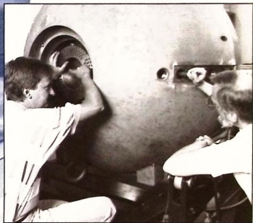
Ronny Falk (t v) och Ivan Jensen kontrollerar att allt fungerar efter slutförd grovmontering.
