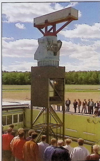
Masten hissas för Antenn 94. Foto: Avionik
