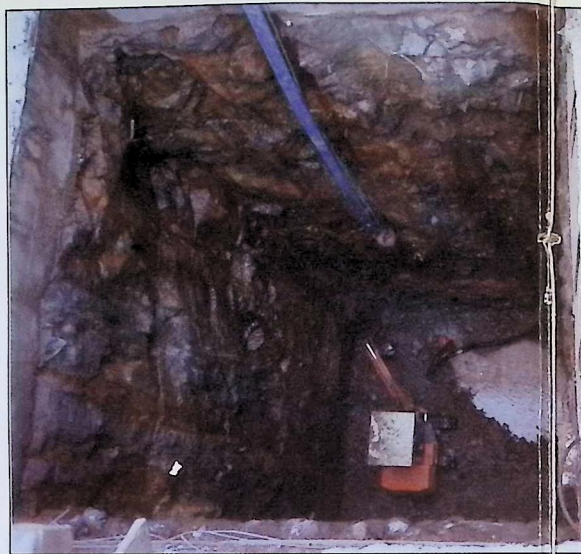
När kampen mot vatten- och lermassorna var över, började man bryta på schaktet för masten. Foto: Avionik
