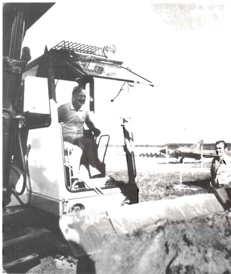
Under överinseende av tfskyddsombudet i B-hallen Pelle "Nisse" Holmgren startade Ingvar Persson bygget med ett rejält tag med grävskopan för utbyggnaden av B-hallen i Malmslätt.
