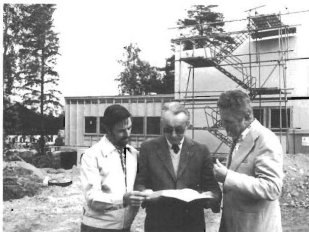
Den nya verkstaden för provning av telekomponenter och underhåll av vapenmateriel vid CVA saknar alltså kontorsutrymmen. Framför verkstadsbygget studerar här representanter för IK 4200 hur kontorsplanerna ser ut. Från vänster: Sven Björklund, John Kardell och Berndt Fröden.
