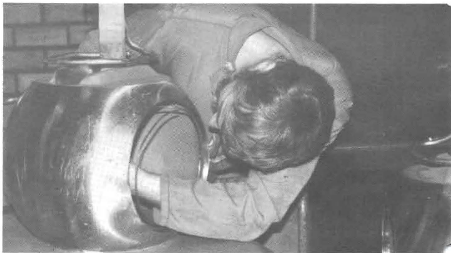
Spänningselektrodernas utformning och "skuggtrådarnas" placering är helt avgörande för resultatet av en jämn ytbeläggning. Lars Bohman gör en sista justering innan kägglorna till ventilerna sänks ned i badet. Foto: Benny Aretun
