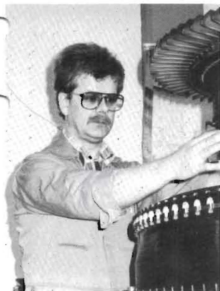
– Vi skulle utan problem ha klarat byte av ledskenekrans på en kampanjmotor inom loppet av fyra veckor, om det inte hade uppstått andra fel som var omöjliga att förutse, säger Dag Löfgren som här arbetar med slutmontering på en av motorerna. Foto: Anne Allard
