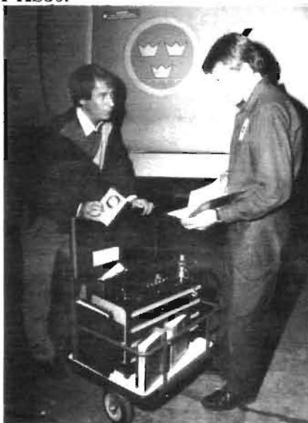
Claes Wennerlund, serviceingenjör inom AS30, bistår löjtnant Jan-Olov Jonsson, F 4, med felsökning i Jakt-Viggens elektroniska system. På bilden ser vi det "yttre minne" som kopplas till flygplanets centraldator för inre prestandakontroll. Foto: Claes Iörnskiöld
