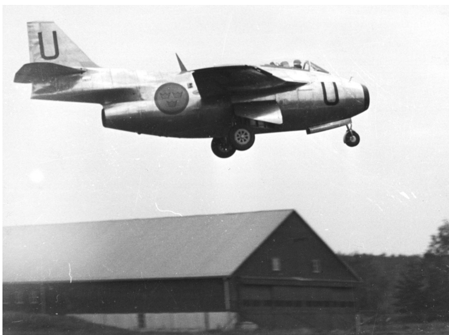
Första provflygningen med Saab typ 29 den 1 september 1948. Landningsstället ville inte fällas in den gången.
