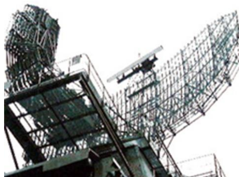
PN-79 antenn i PS-66 radarantenn (Foto FHT)
